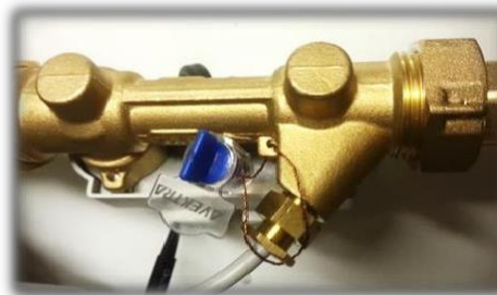
Рисунок 4. Пломба на проточной части.
