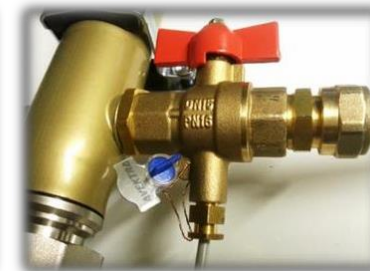
Рисунок 5. Пломба на шаровом кране.
